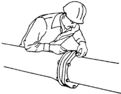
3. Empujar el prensaestopas hacia el extremo de campana y centrarlo alrededor del caño con la pestaña contra la junta. Insertar los bulones y ajustar las tuercas manualmente. Hacer la deflexión después del montaje de la unión pero antes de ajustar los bulones.
